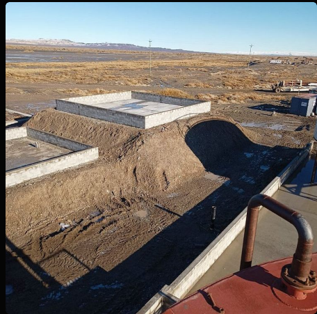
Obra Civil en Batería Puerto Vera
